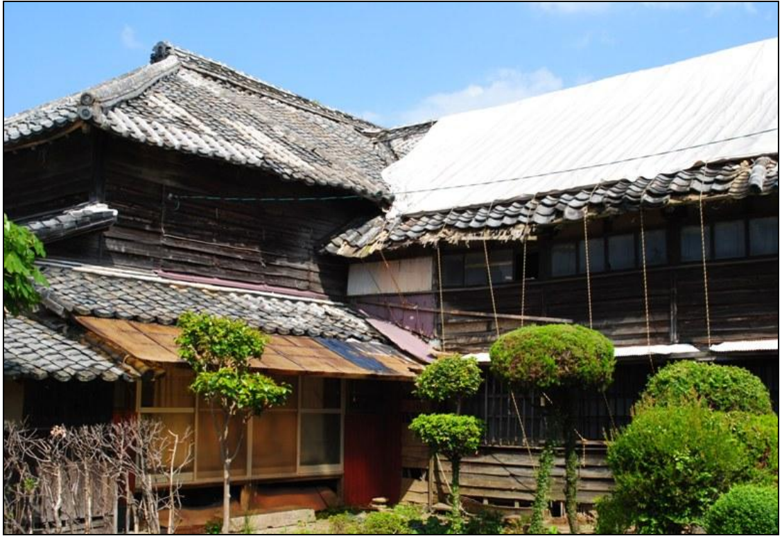
北むねと南むねが交差する部分（雨漏り防止の防水シート敷設後）
