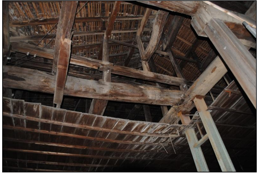
南むね小屋組、折れた梁を鉄骨柱で補強
