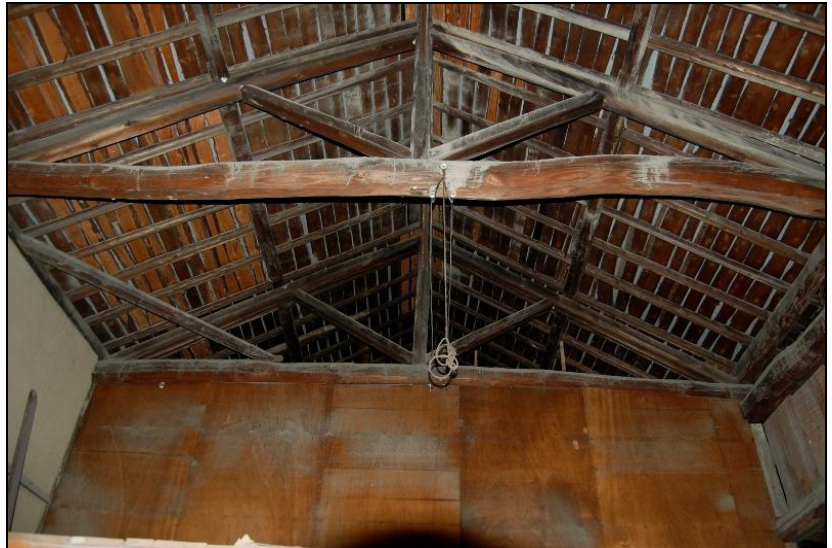
倉庫棟のトラスの小屋組
