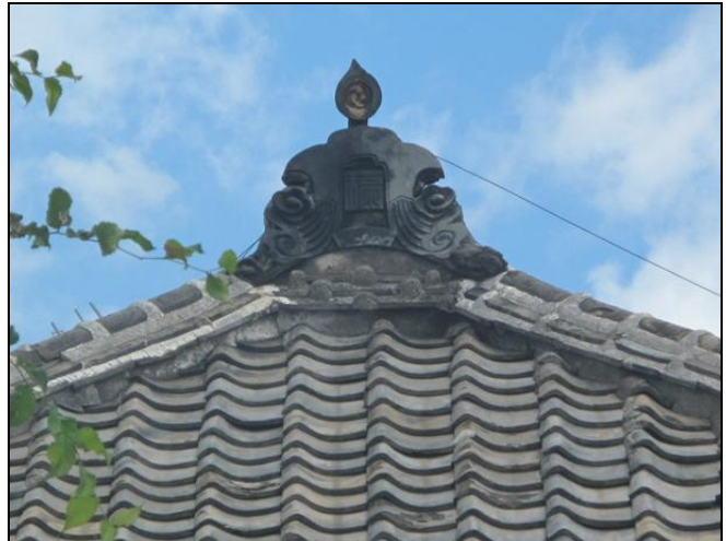
北むねと南むねが交差する部分（雨漏り防止の防水シート敷設後）
