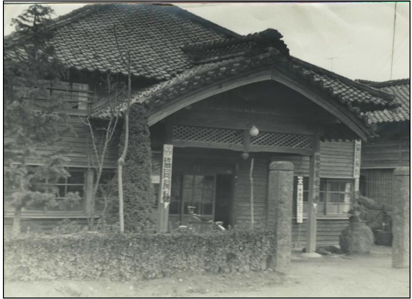
昭和35年頃の南側外観
