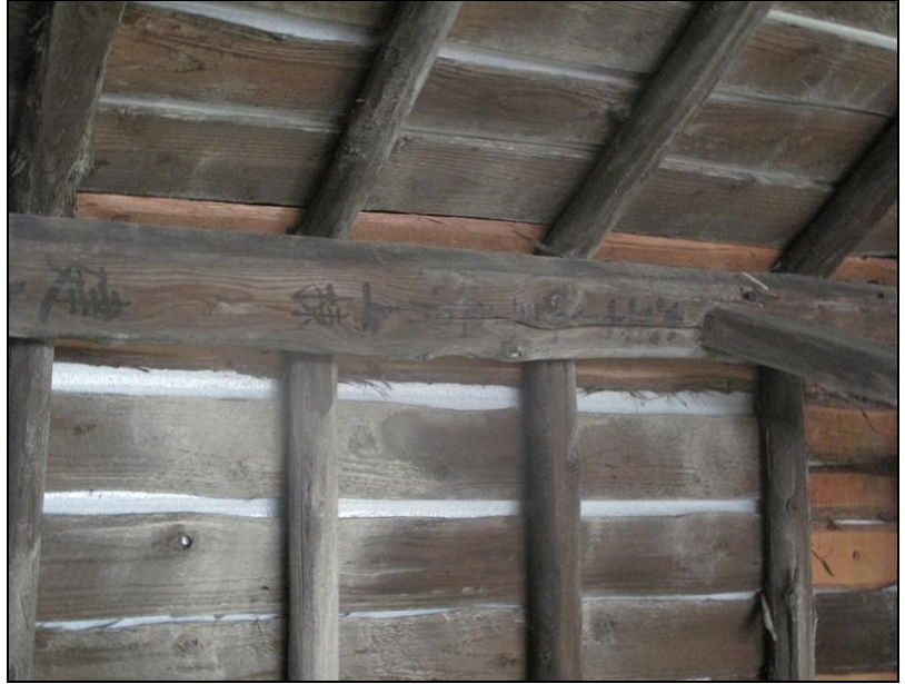
倉庫棟の棟木に書かれた墨書
