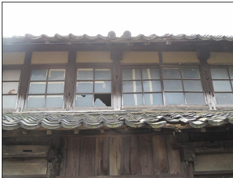
千鳥破風の玄関ポーチの痕跡がある北側外観
