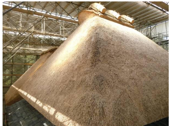
修理工事が進む旧増田家住宅
