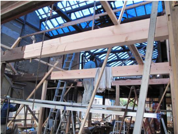
修理中の現場 梁の入替え中
